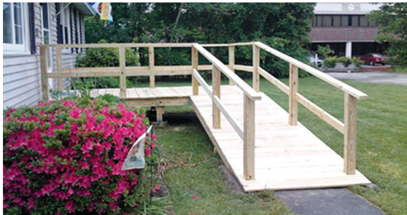
รูปที่ 16 : ตัวอย่างทางลาดเข้าอาคาร
