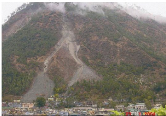
ດິນເຈື່ອນທັບບ້ານເຮືອນ (Landslide in a village)
